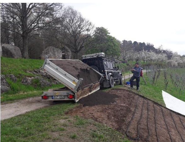
Rasenerde vorsichtig über Fläche verteilen, ohne Perlschlauch zu beschädigen
