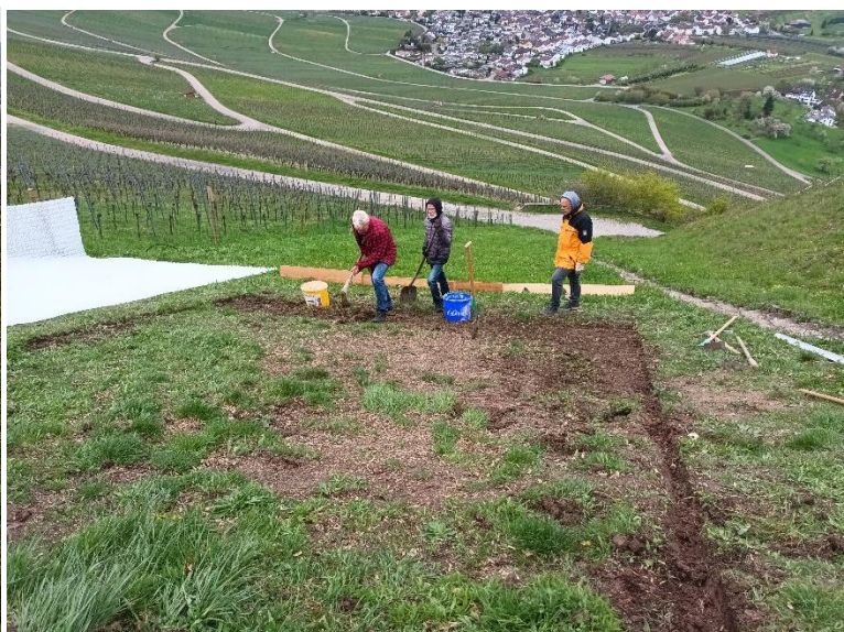
Auszugrabende Fläche für Bagger markieren und rings rum ein Spaten breit von Hand ausgraben.
