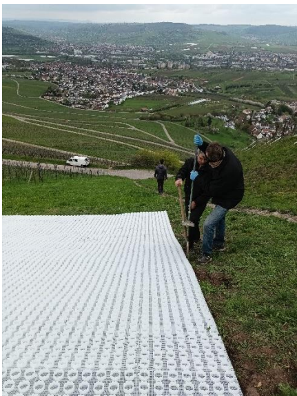
Auszugrabende Fläche für Bagger markieren und rings rum ein Spaten breit von Hand ausgraben.
