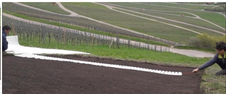
Rasenerde eben ziehen mit Holzschieber und Kiesgitter (Remstaler Nivilierpatent)
