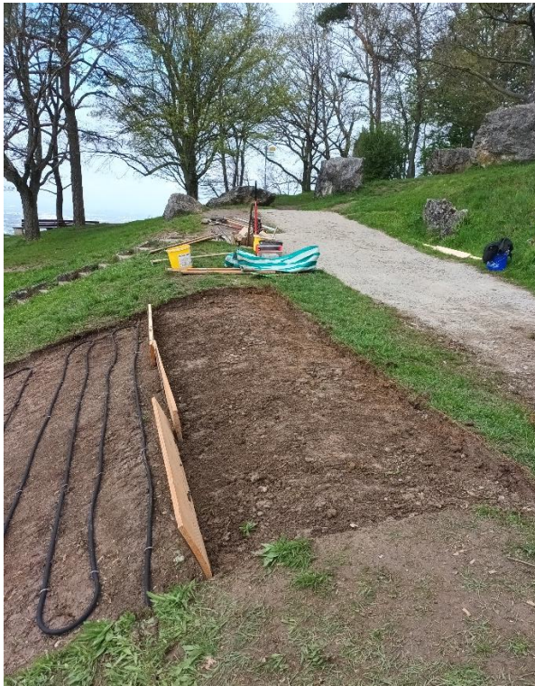
Oberhalb der Waben zusätzlich 1,4 m breit für 8 qm Rollrasen ausgegraben
