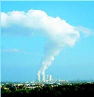
Wir sehen hier einen künstlich erzeugten Thermikschlauch, der bis zu einer bestimmten Höhe, der Inversionsuntergrenze, reicht. Der Thermikaufstieg wird also hier durch eine Inversion begrenzt. Die horizontale Ausbreitung der Wolke lässt das sehr schön erkennen. Sie kann nicht mehr aufsteigen und breitet sich in Windrichtung aus. Foto: Christian Schulz
