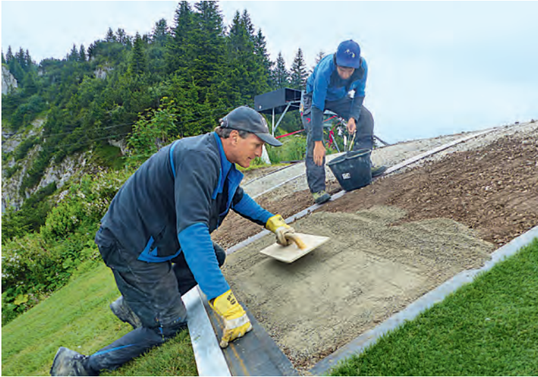
↑ Sand-/Splütmisch wird eingearbeitet.
