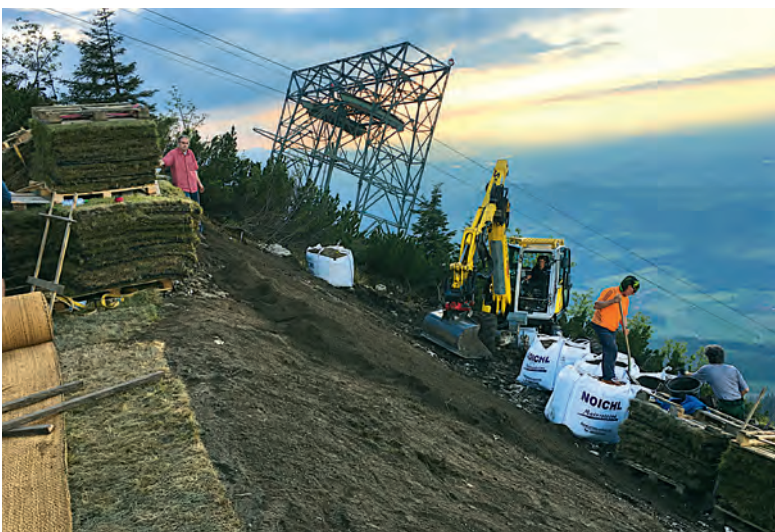
↑ Arbeiten bis in die Dämmerung hinein
