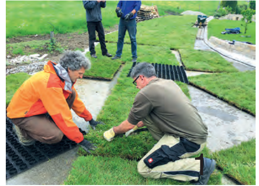
↑ Aufbringen der Securatek Kieswaben auf einer Straße. Zuvor wurden immer vier Elemente mit dünnem Draht verbunden. Dann Aufbringen und Schneiden des Rolltrassens auf den Kieswaben.
