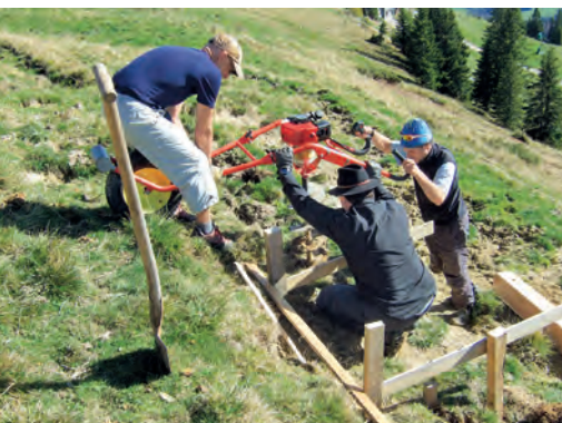
Die Punktfundamente werden gesetzt
