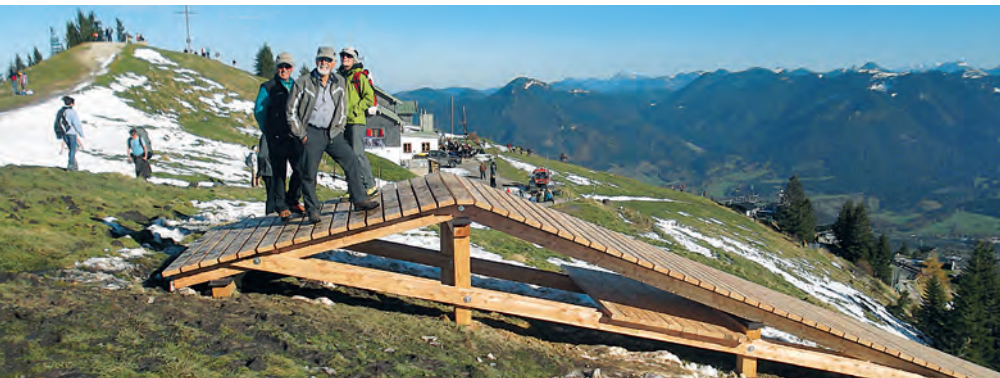
Die Rampe ist fertig
