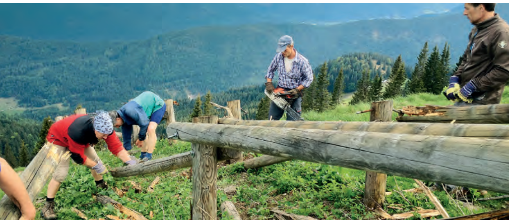
Abbau der alten Rampe
