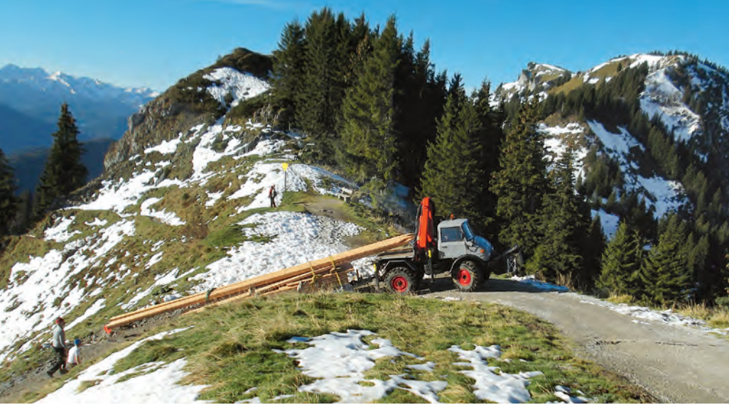
Transport der Rampenteile
