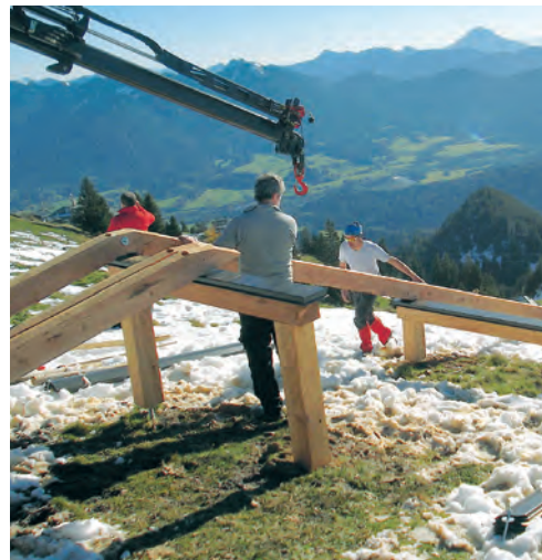
Aufbau der Rampenteile
