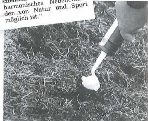
Der Kleber läuft beim Aufbringen langsam über die Schraube und beginnt nach ca. 20 Minuten auszuhärten.
