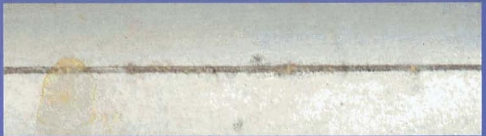
An einem Kratzer in der Eloxalschicht zeigen sich erste Korrosionserscheinungen
